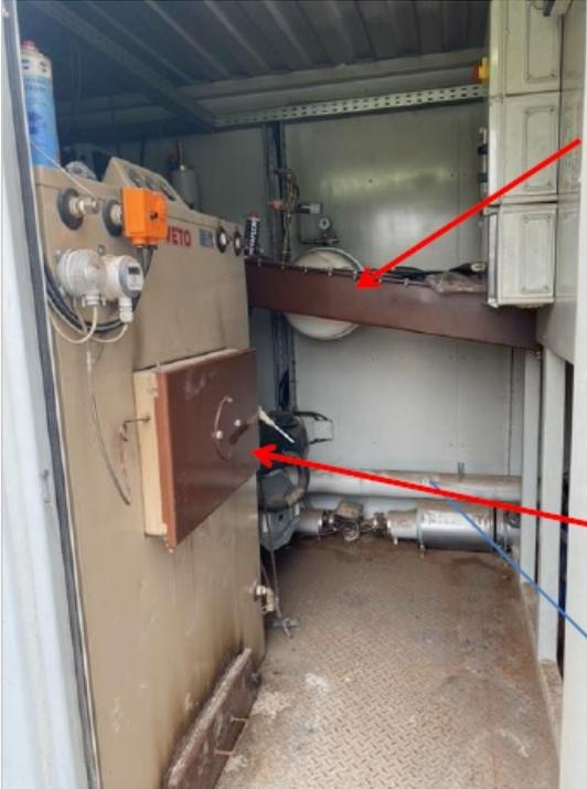
Füllschacht zwischen dem Vorratsbehälter und dem Heizkessel, die zusammen im Container untergebracht sind.
